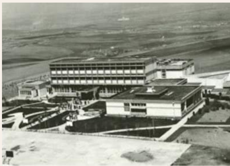
AFL 1964 -- Derslikler ve idare binası İssız bir dağ başında yatılı okul
