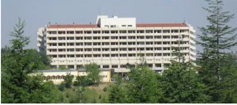
1988'de Bilkent Rektörlük binası Üniversite bu bina ve lojmanlardan ibaret idi
